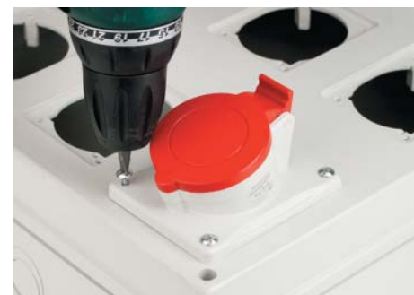
Монтаж розетки на 32 А
